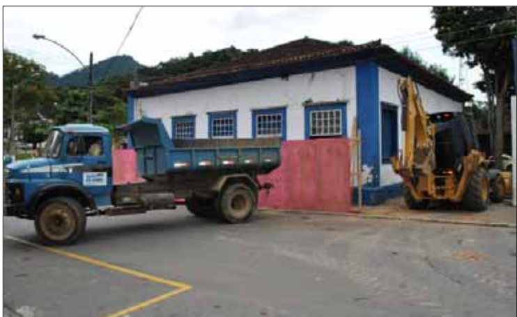
Casa da Cultura já está em obras
