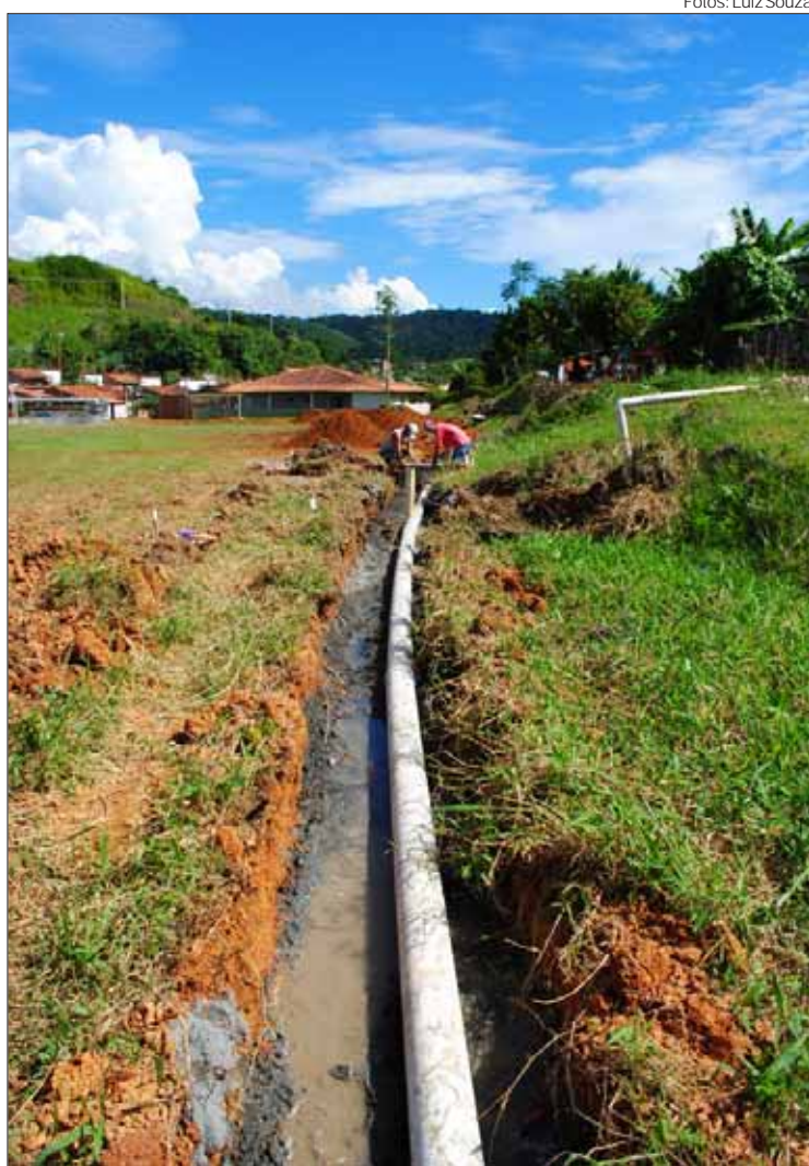
Construção da rede de esgoto no Alambari
