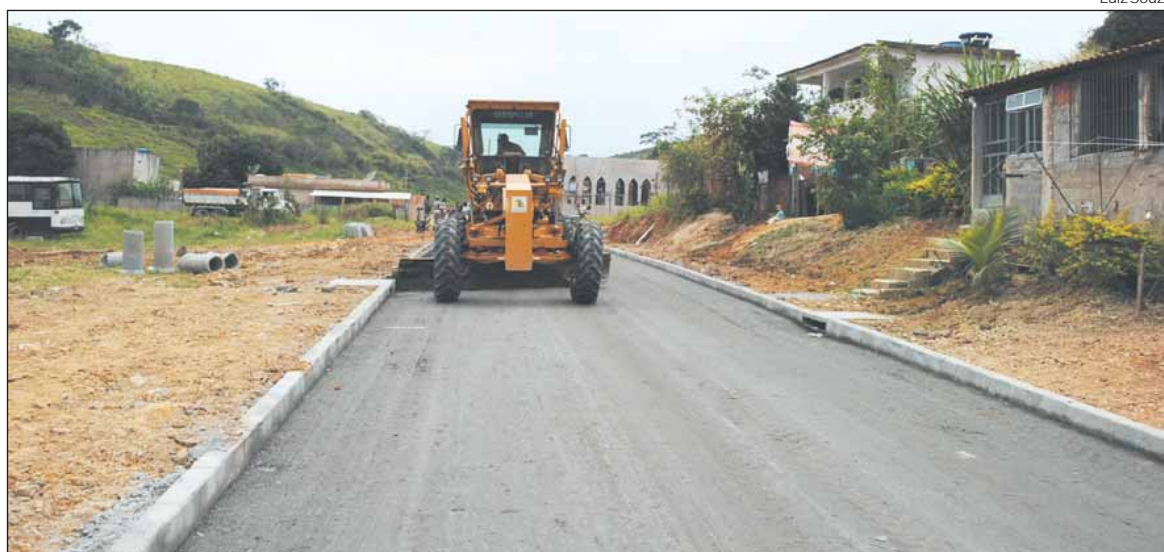
Rua é asfaltada no Alambari, visando à construção de um conjunto habitacional
