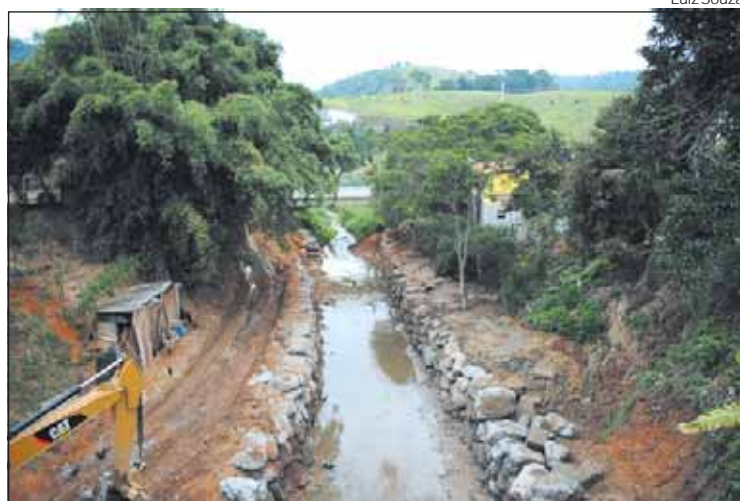
Córrego Rio Claro com a contenção adiantada
