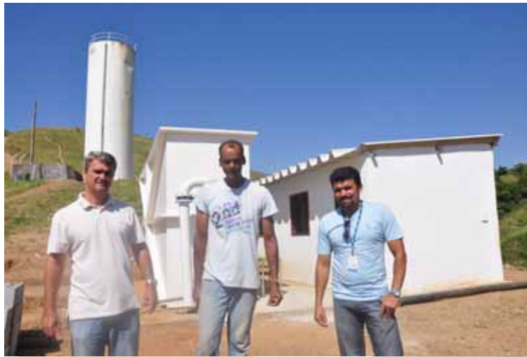
Em breve ETA estará funcionando totalmente
